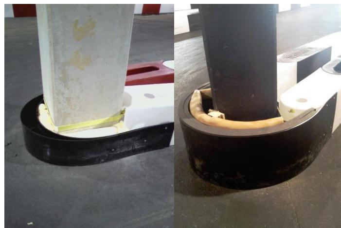
Si une autre ligne repart après le poteau, il faudra fixer une bande noire au 2 blocs qui entourent le poteau en mettant derrière la bande noire, de la mousse ou un pneu
